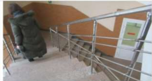
Фото 38. Состояние внутренних помещений 2 этажа.
