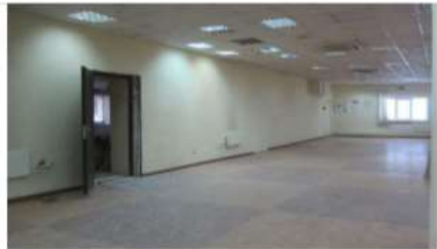
Фото 66. Состояние внутренних помещений 4 этажа (мансарда).
