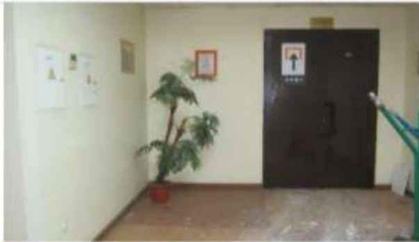
Фото 67. Состояние внутренних помещений 4 этажа (мансарда).
