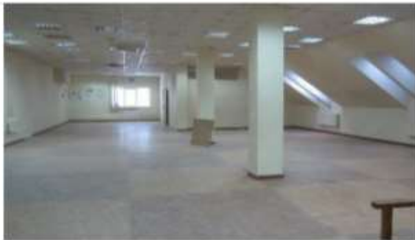
Фото 65. Состояние внутренних помещений 4 этажа (мансарда).
