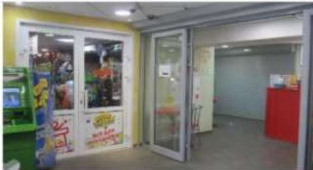
Фото 37. Состояние внутренних помещений 1 этажа.
