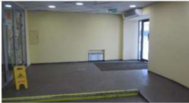
Фото 35. Состояние внутренних помещений 1 этажа.
