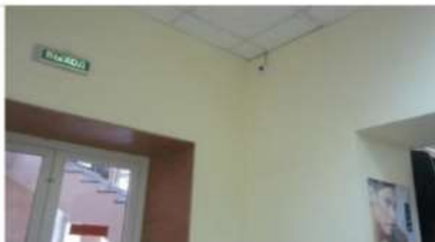
Фото 43. Состояние внутренних помещений 2 этажа.
